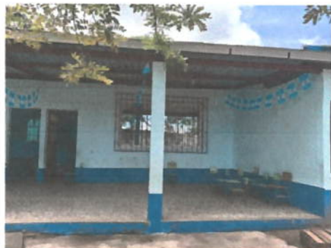
PINTURA EN MUROS INTERIOR Y EXTERIOR
