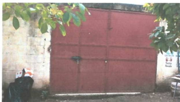
MANTENIMIENTO A PORTONES
